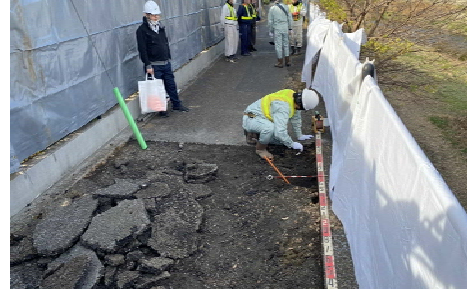
路盤等の確認状況
