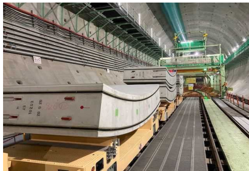
セグメント搬送状況 (令和5年1月19日)
