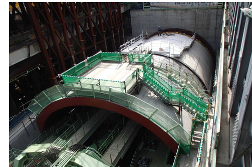
シールド機組立完了状況 (平成31年1月27日)
