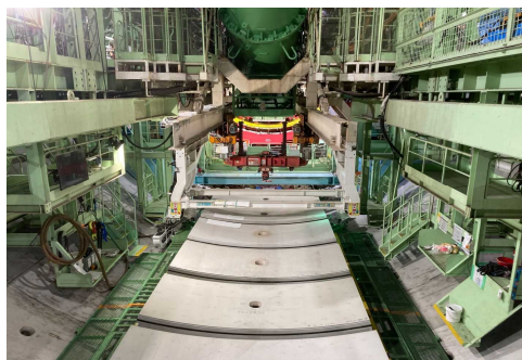
セグメント組立状況 (令和5年2月28日)
