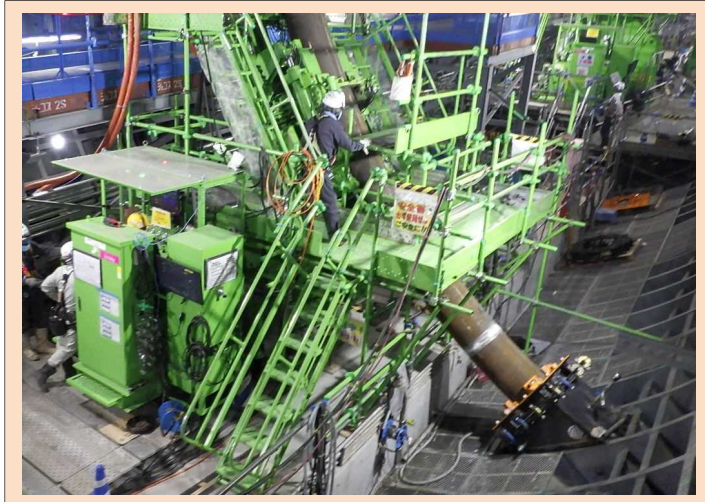
Fランプ接続区間の工事状況 令和4年11月～現在
