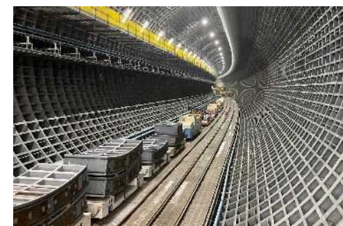
セグメント搬送状況 (令和5年5月22日)
