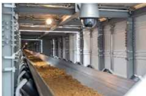
シールドマシンによって掘削した土砂を、 ベルトコンベアに乗せて仮置き場へ搬送する状況 (令和元年9月18日)
