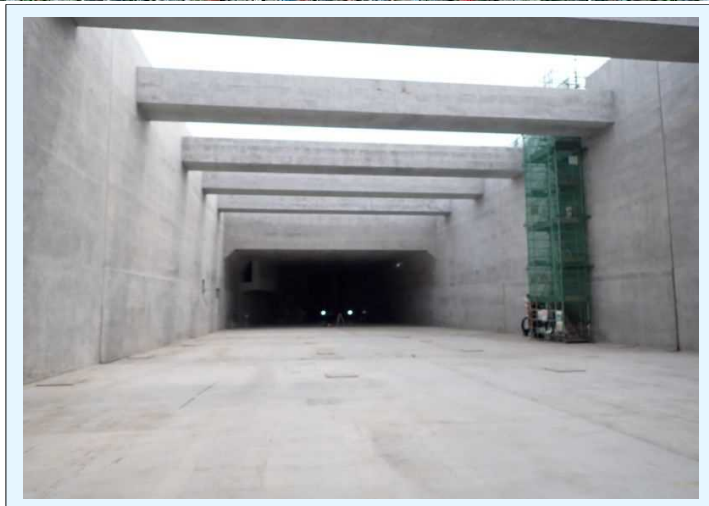
Bランプ料金所部 施工完了 令和2年6月
