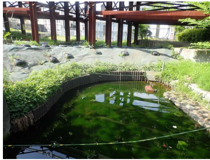
土砂流入防止措置の状況 (R5.4)
