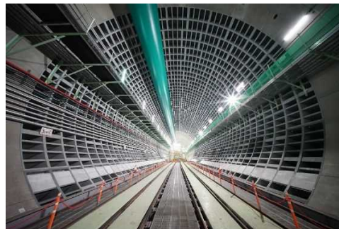
構築されたトンネル内(鋼製セグメント) (令和5年2月17日)
