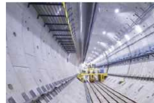
構築されたトンネル内(合成セグメント) (令和2年7月18日)
