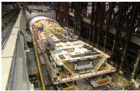
シールドマシンの後続台車の組立状況 (平成30年10月25日)
